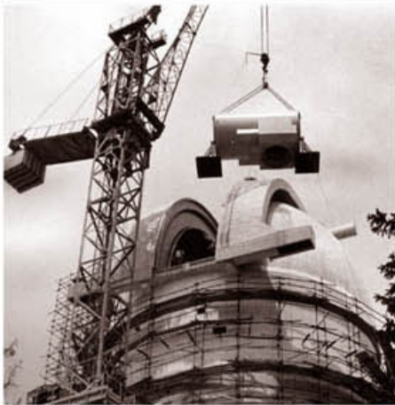
Монтаж на тубуса и главното огледало на 2-м телескоп (1978 г.)
