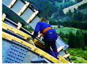
Със сглобен, облицован с алуминиеви панели и боядисан в бяло купол, кулата е готова да приеме частите на 2-м телескоп [кадри от докум. филм "Телескопът" (СНПДФ "Време", автори: Д. Китанов, Б. Ковачев, М. Ханне, Ива. Хубенов и др. )]
