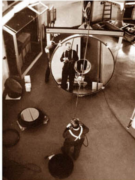
Монтаж на тубуса и главното огледало на 2-м телескоп (1978 г.)
