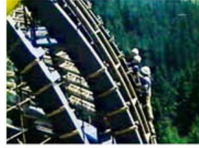
Със сглобен, облицован с алуминиеви панели и боядисан в бяло купол, кулата е готова да приеме частите на 2-м телескоп [кадри от докум. филм "Телескопът" (СНПДФ "Време", автори: Д. Китанов, Б. Ковачев, М. Ханне, Ива. Хубенов и др. )]
