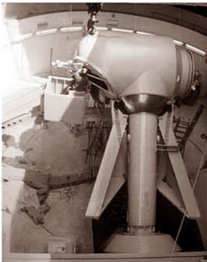
Монтаж на тубуса и главното огледало на 2-м телескоп (1978 г.)
