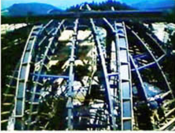
Със сглобен, облицован с алуминиеви панели и боядисан в бяло купол, кулата е готова да приеме частите на 2-м телескоп [кадри от докум. филм "Телескопът" (СНПДФ "Време", автори: Д. Китанов, Б. Ковачев, М. Ханне, Ива. Хубенов и др. )]
