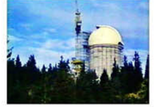
Със сглобен, облицован с алуминиеви панели и боядисан в бяло купол, кулата е готова да приеме частите на 2-м телескоп [кадри от докум. филм "Телескопът" (СНПДФ "Време", автори: Д. Китанов, Б. Ковачев, М. Ханне, Ива. Хубенов и др. )]
