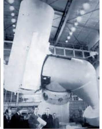
Със сглобен, облицован с алуминиеви панели и боядисан в бяло купол, кулата е готова да приеме частите на 2-м телескоп [кадри от докум. филм "Телескопът" (СНПДФ "Време", автори: Д. Китанов, Б. Ковачев, М. Ханне, Ива. Хубенов и др. )]
